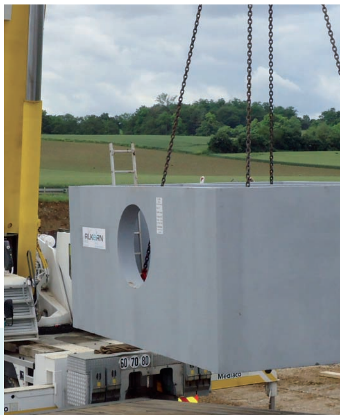
Mise en place d'un ouvrage de régulation Alkern, en béton préfabriqué.
