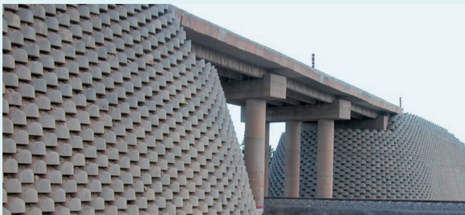
Mur de soutènement Atalus 50, réalisé en éléments béton préfabriqués par Alkern.
